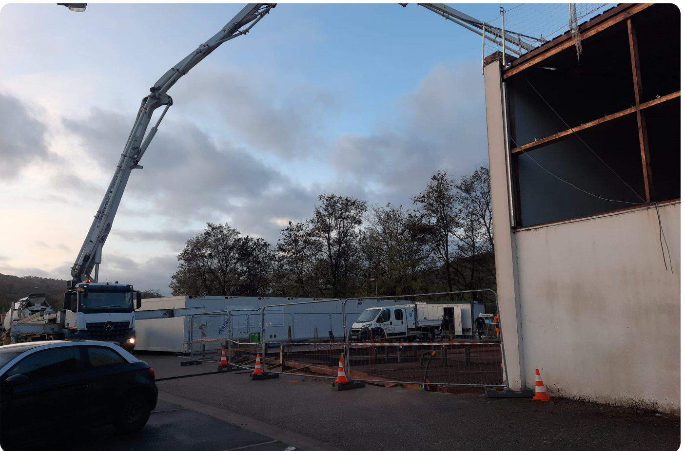
Préparation pour le coulage du béton
