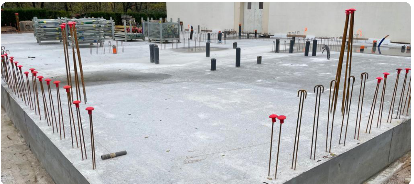
Dalle terminée sur la face avant
